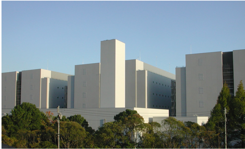
中央のタワー建屋は煙突 4 本を収納。下がエネルギー棟、一段下り右が動物焼却炉の棟
