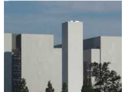
手前の細い建物に3本の煙突を収納（写真は午後）
